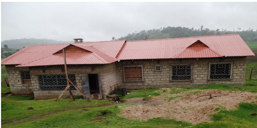
Het is een multifunctioneel gebouw: huisvesting fr. San (ca 20 %), docentenkamer, directiekamer, huisvesting enkele docenten en opvang van kwetsbare meisjes. Wij hebben hieraan € 14.000 bijgedragen.
